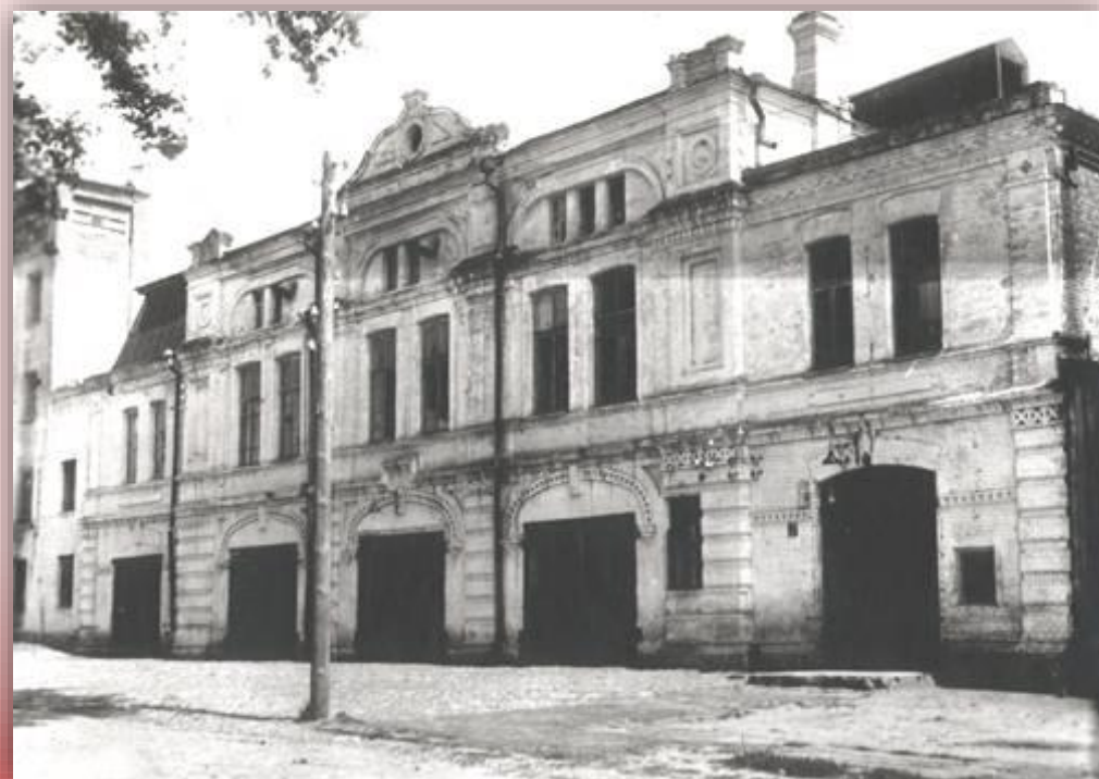
Фото. Пожарное депо в Бобруйске
